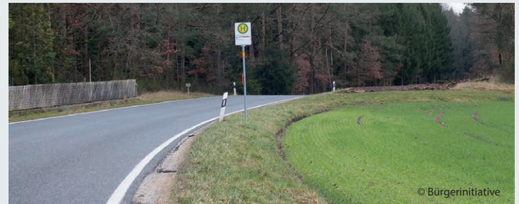
Diese Haltestelle wurde wegen mangelnder Verkehrssicherheit wieder abgebaut.
