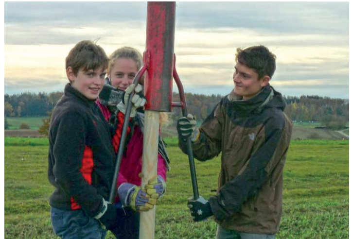
Mika Siegl, Luca Grümmer und Vincent Basso beim Einrammen eines Zaunpfostens
