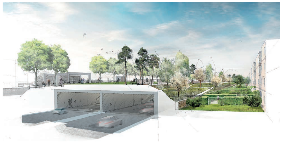
Tunneleinfahrt aus dem Süden
