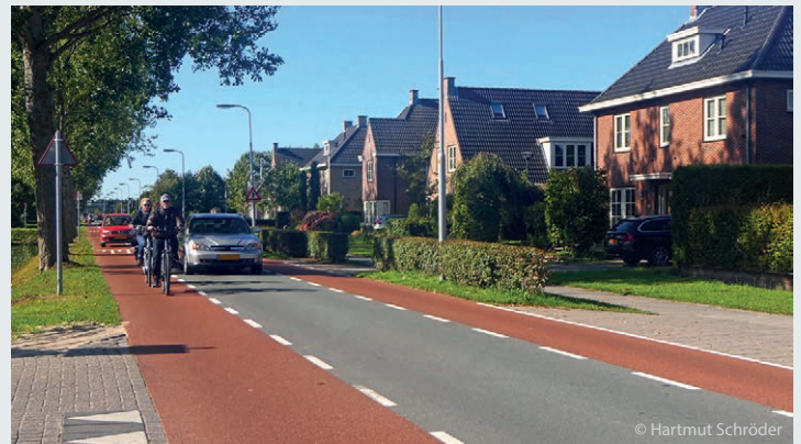
Links und rechts neben der einspurigen Straße (keine Einbahnstraße) gibt es breite Radfahrstreifen. © Hartmut Schröder
