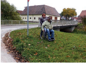
Wegen fehlender Bordsteinabsenkung musste durch die „Grünanlagen“ gefahren werden
