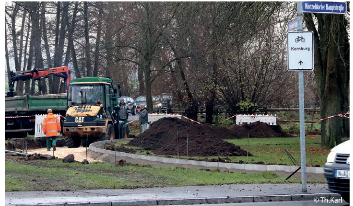
Mit der Verlegung des Radwegs hinter der Fahrzeughalle begannen die Baumaßnahmen zur Feuerwehrhof-Erweiterung.
