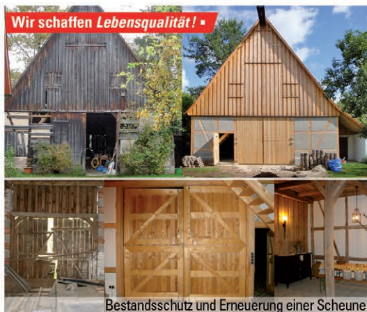
Bestandsschutz und Erneuerung einer Scheune
