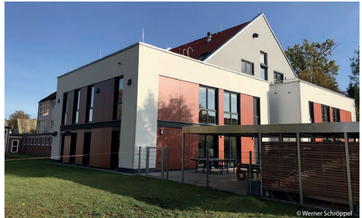
Kurze Wege -- architektonisch gelungener Anbau des neuen Hortgebäudes direkt an die bestehende Grundschule. Derzeit errichtet die Marktgemeinde Wendelstein noch einen großzügigen Spielplatz für Kinder unterschiedlicher Altersklassen direkt neben dem Hort.
