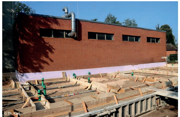
Deutlich sind mittlerweile die Räume für den Erweiterungsbau an den Fundamenten zu erkennen.
