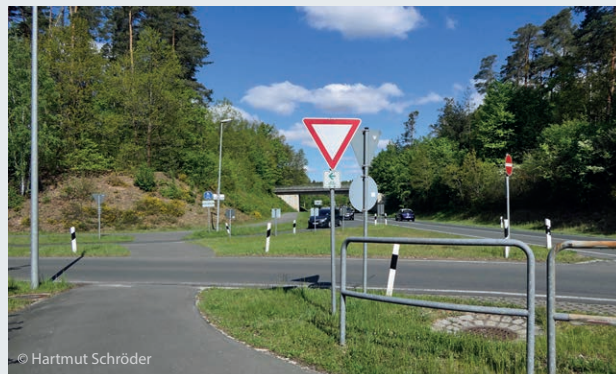
Wendelstein Mitte/St 2225: Der Radverkehr muss dem Querverkehr Vorfahrt gewähren. Keine Markierung auf der Straße.
