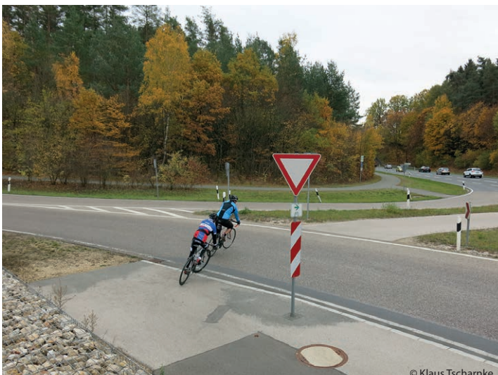
Schlechter gehts kaum: Gefährliche Radweg-Querung an der Abfahrt Röthenbach des Zollhaus-Radwegs
