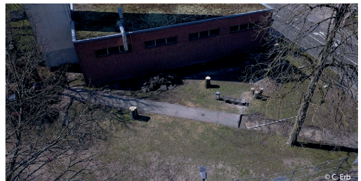
Der alte Asphaltbelag wird entfernt.
