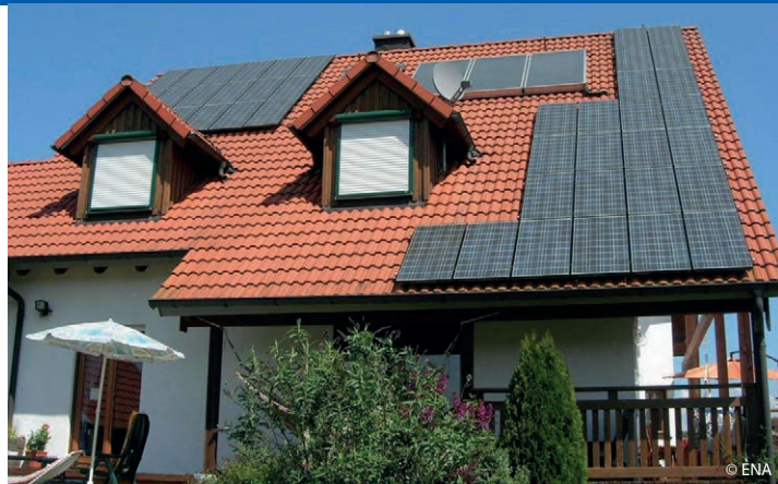
So sieht es inzwischen auf vielen Dächern im Landkreis Roth aus. Hier wird die Sonne zum einen über eine Solarthermie-Anlage zur Warmwassererwärmung genutzt, zum anderen wird mit einer PV-Anlage Strom erzeugt.
