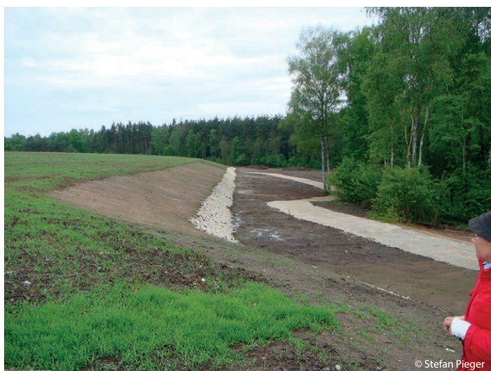
Bis zu 15 m tiefe Betonwände sollen die Grundwasserverseuchung reduzieren
