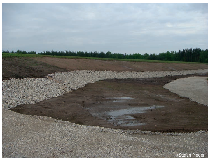
Der Nato23 Bereich in der Muna kurz nach der Sanierung im Jahre 2009
