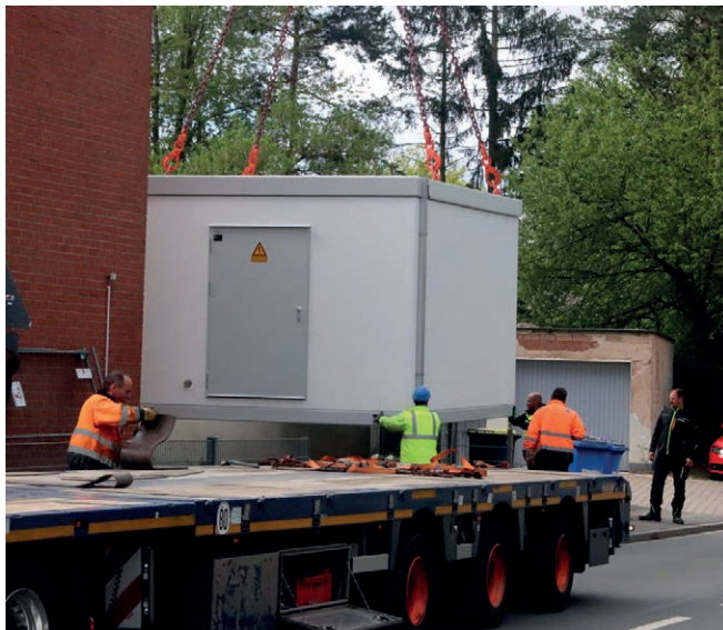
Der Kran bringt die Zelle zum Fundament.
