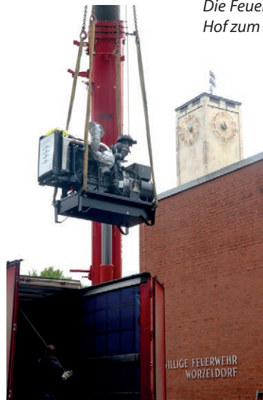
Der Motor hängt am Kranhaken.
