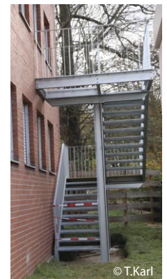
Auf der Rückseite des Nebengebäudes ist bereits die Fluchttreppe errichtet.
