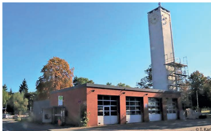
Die Fahrzeughalle ist gerüstfrei, am Turm steht das Gerüst zum Anbau der Übungsbalkone.
