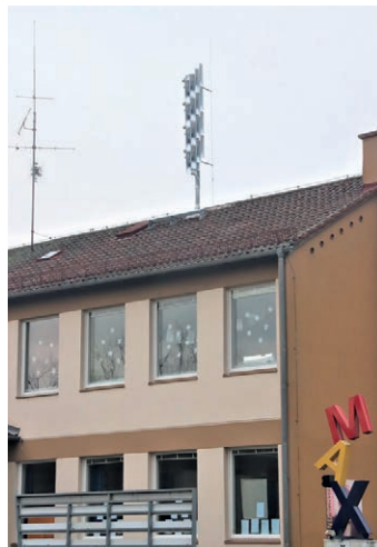
Auch die Sirene auf dem Dach der Worzeldorfer Max-Beckmann-Grundschule wird bei Feueralarm mit ausgelöst.
