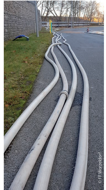
Mit einem dicken Bündel Schläuche wurde die Löschwasserversorgung gesichert.
