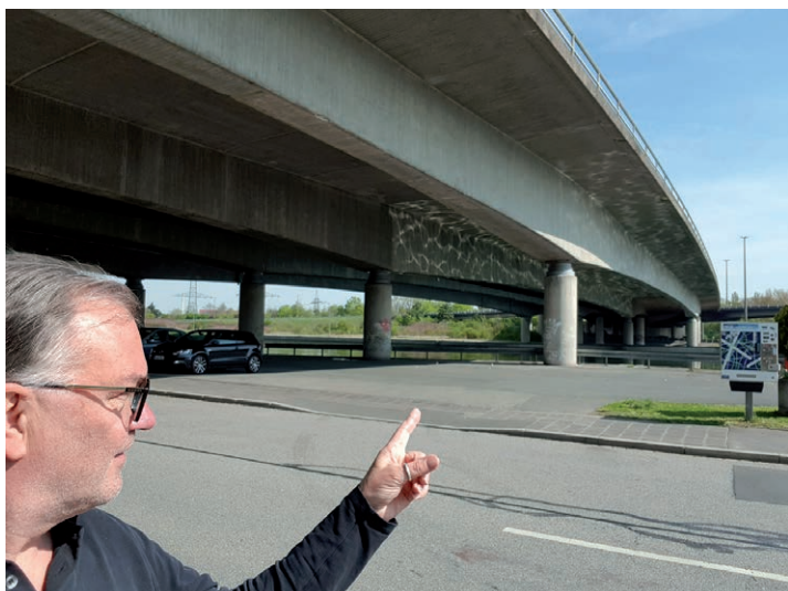
Diese Brücke wird erneuert
