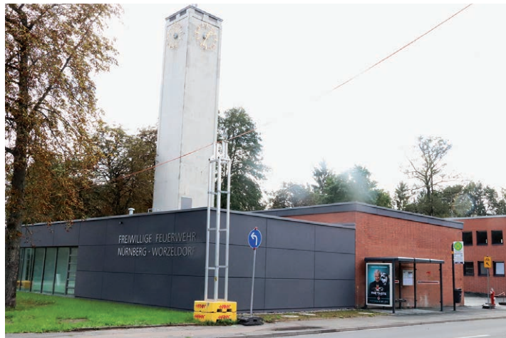
Im Vordergrund der fertig erstellte Bauabschnitt 1, im Hintergrund das Nebengebäude als Bauabschnitt 2
