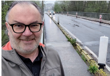
Rennmühlbrücke in Katzwang
