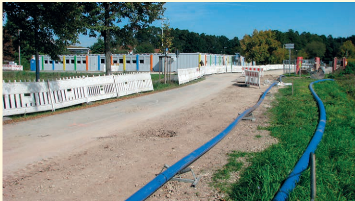
Die Schülerinnen und Schüler des kooperativen Ganztages nutzen bereits die Container bei der Grundschule in Großschwarzenlohe. Im Mittelweg werden verschiedene Erschließungsmaßnahmen durchgeführt. Die Straße soll Ende Oktober wieder für den Verkehr freigegeben werden.
