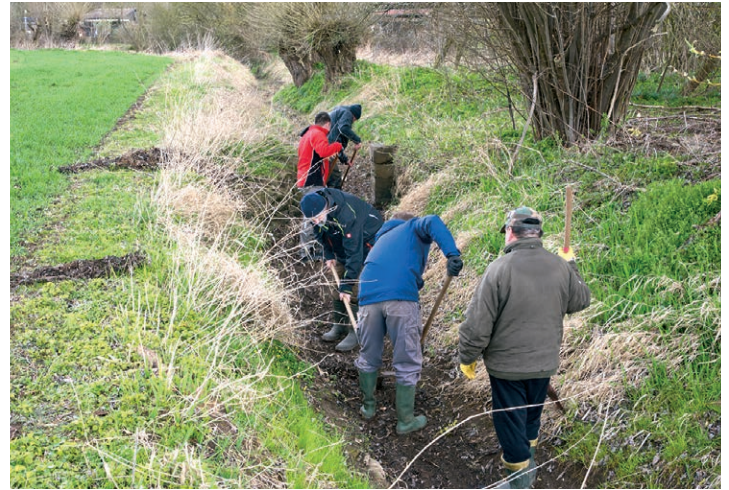
Mit Hacke, Schaufel und Heugabel wird Bewuchs und Unrat aus dem Graben beseitigt.
