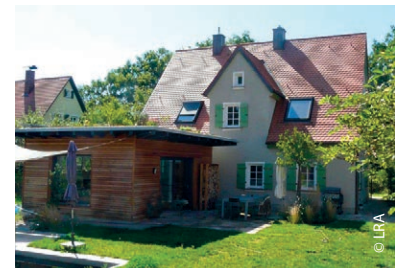
Aus Alt mach Neu – eine erfolgreiche Kernsanierung zum Effizienzhaus
