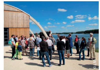
Besichtigung Wasserkraft am Rothsee
